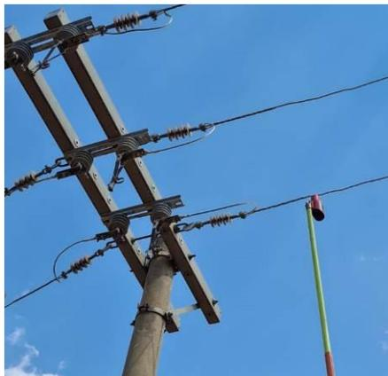
Foto 2: Teste de ausência de tensão
